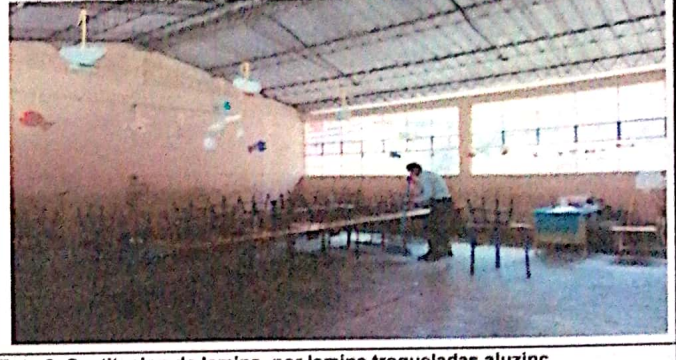
Foto 2: Sustitucion de lamina, por lamina troqueladas aluzinc
