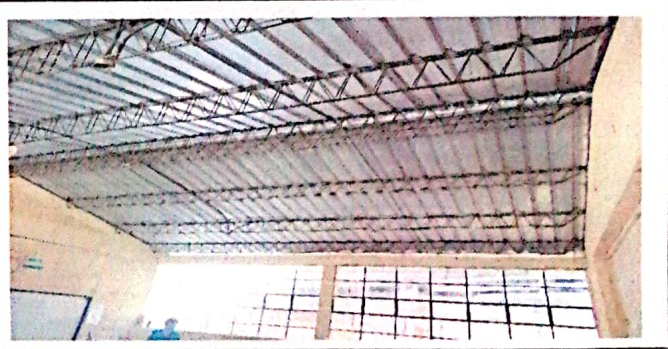
Foto 6: Sustitucion de Capote zintroalum.
